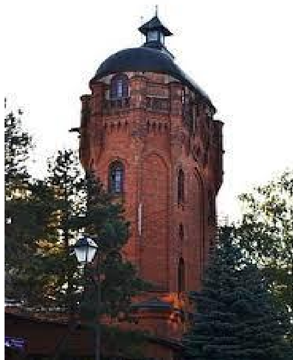
Fot. 9. Wieża Ciśnień w Żytomierzu
