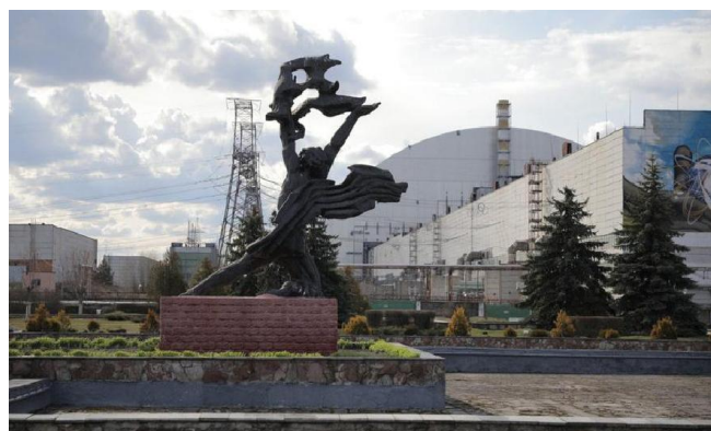
Fot. 21. Elektrownia w kwietniu 2022 r. po wycofaniu się Rosjan
